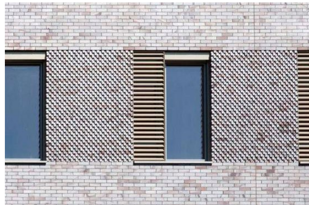
detail: afwisseling verticale en horizontale textuur
