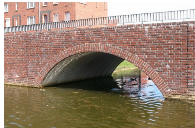
watergangen: duiker met gemetselde zijcanten
