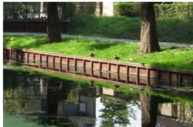
overgang openbaar-privé: houten beschoeiing
