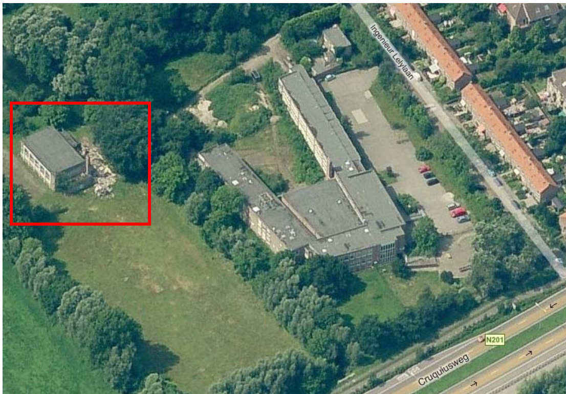
Figuur 1: Locatie gymzaal en puin
