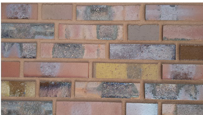
Figuur 6: voorbeeld metselwerk Hagemeister - Baltrum
