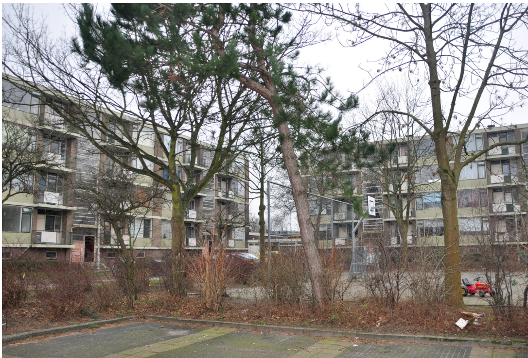
Overzicht bestaande bebouwing aan de Simon van Haerlemstraat .
