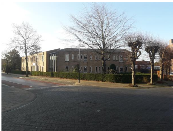
Foto 1: Voorzijde kantoorpand (Maerten van Heemskerckstraat 34)
