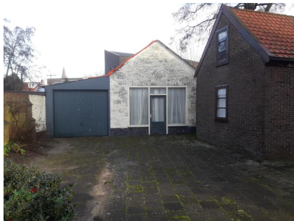
Foto 8: Zijkant woning met schuur en oprit.
