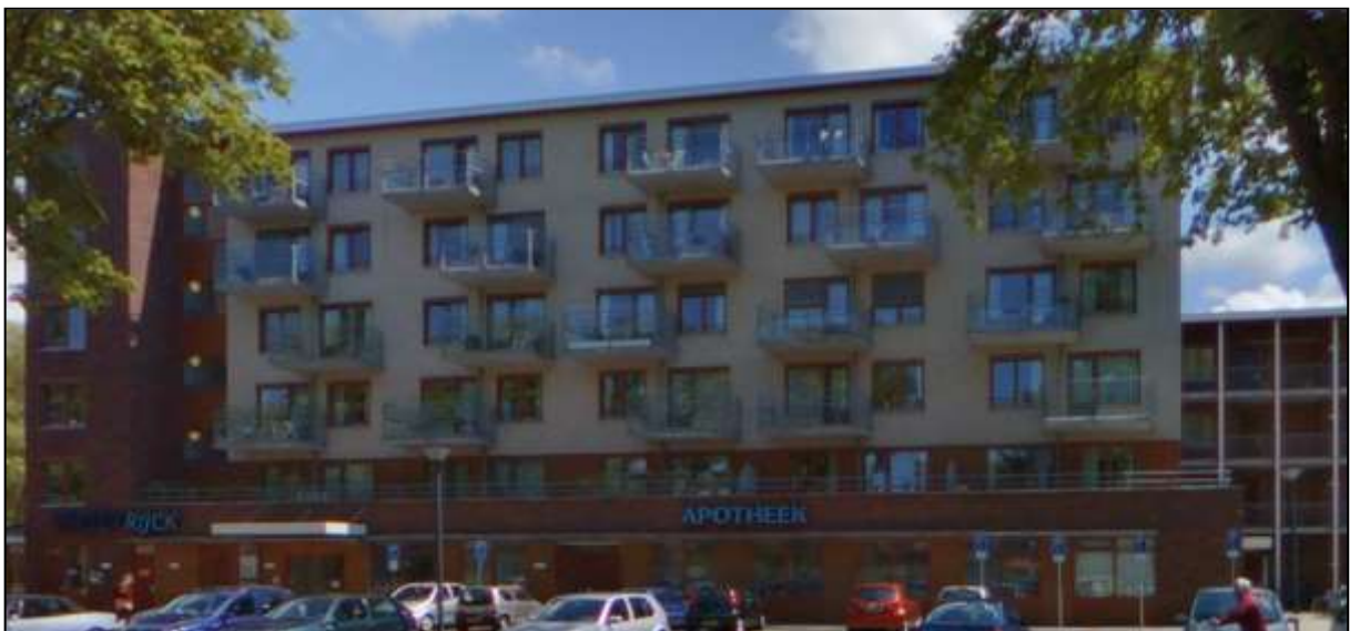
Afbeelding: Appartementencomplex Beneluxlaan.
