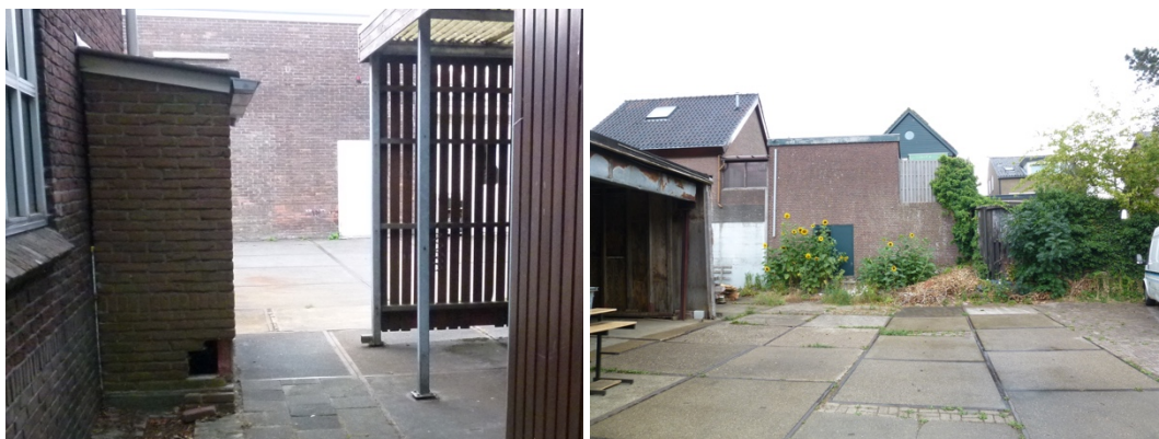
Links een gat in de bebouwing op het terrein waar een marter naar binnen kan. Rechts een deel van de noordoostelijke bebouwing en onverharde delen met struweel en ruigte.
