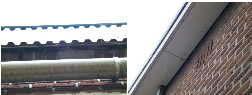
Links ruimte tussen de dakrand en de bakstenen gevel, rechts een ventilatieopening en ruimte tussen de goetombouw en de bakstenen gevel.
