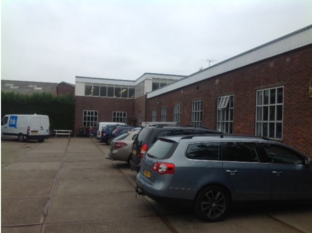
Foto 9, overzicht parkeerplaats in noordoostelijke richting kijkend.
