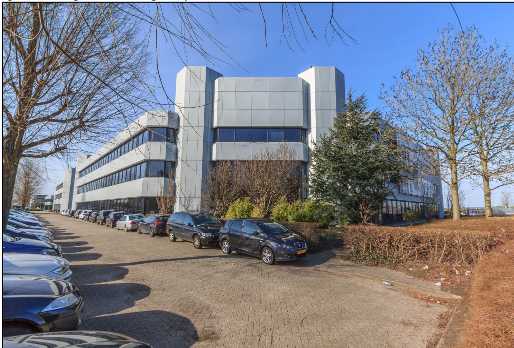
figuur 1. huidig aanzicht voorgevel pand
