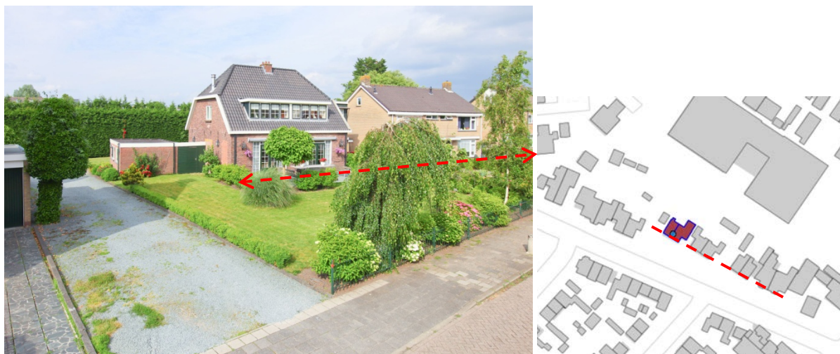
afb.9 Bestaande situatie, naar achter liggende woning
