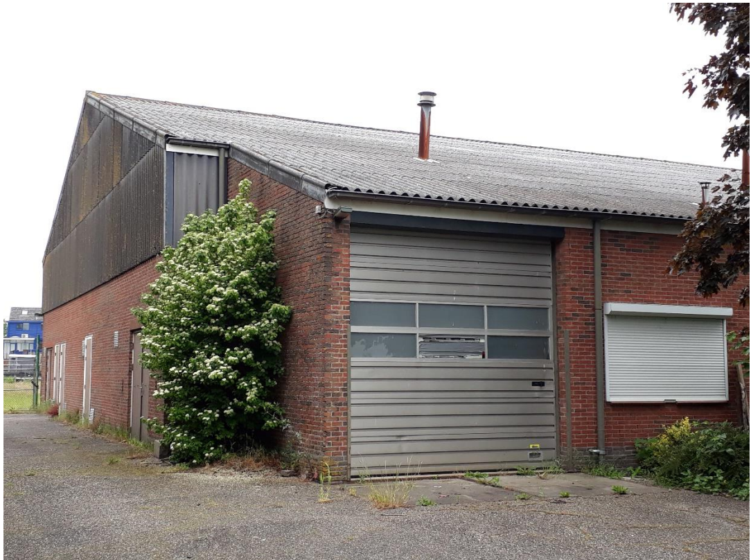
Loods met potenties voor gebouwbewonende broedvogels en vleermuizen
