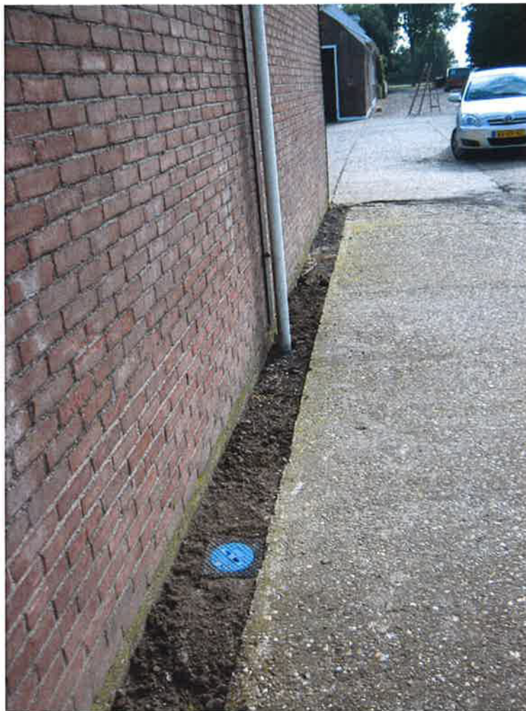
Foto 3: tpv ondergrondse tank peilbuis 13 (foto oostelijk gericht)
