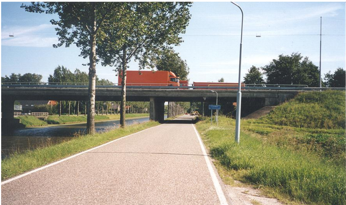
Figuur 2.3 Brug van de A9 over Hoofdvaart
