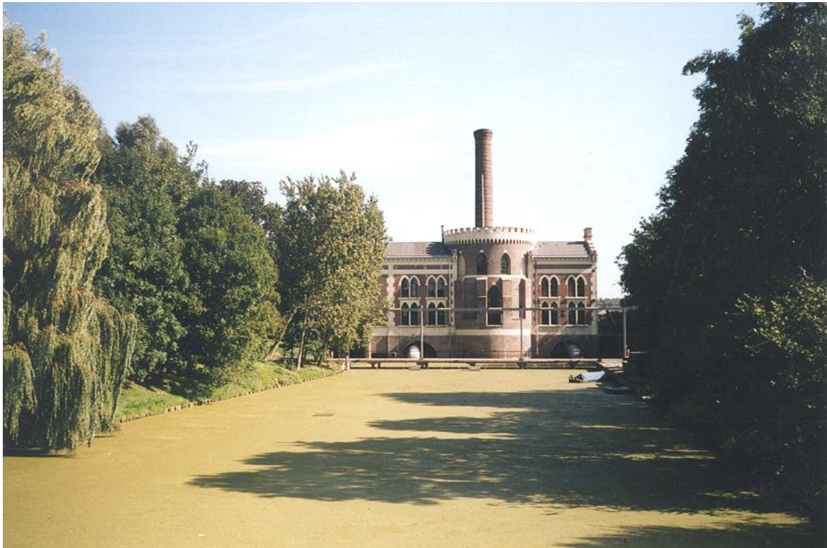
Figuur 2.1 Gemaal Lijnden
