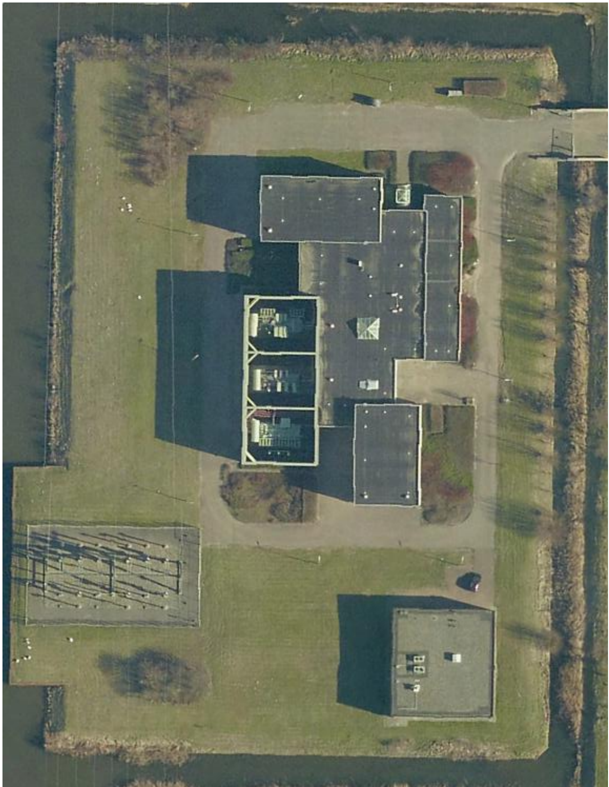
Figuur 1: Luchtfoto hoogspanningsstation Haarlemmermeer
