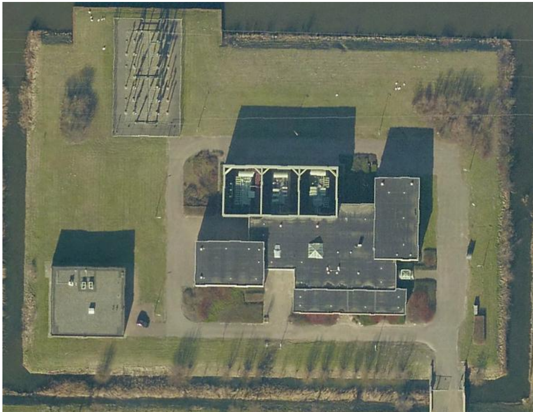
Figuur 1, Luchtfoto van hoogspanningsstation Haarlemmermeer
