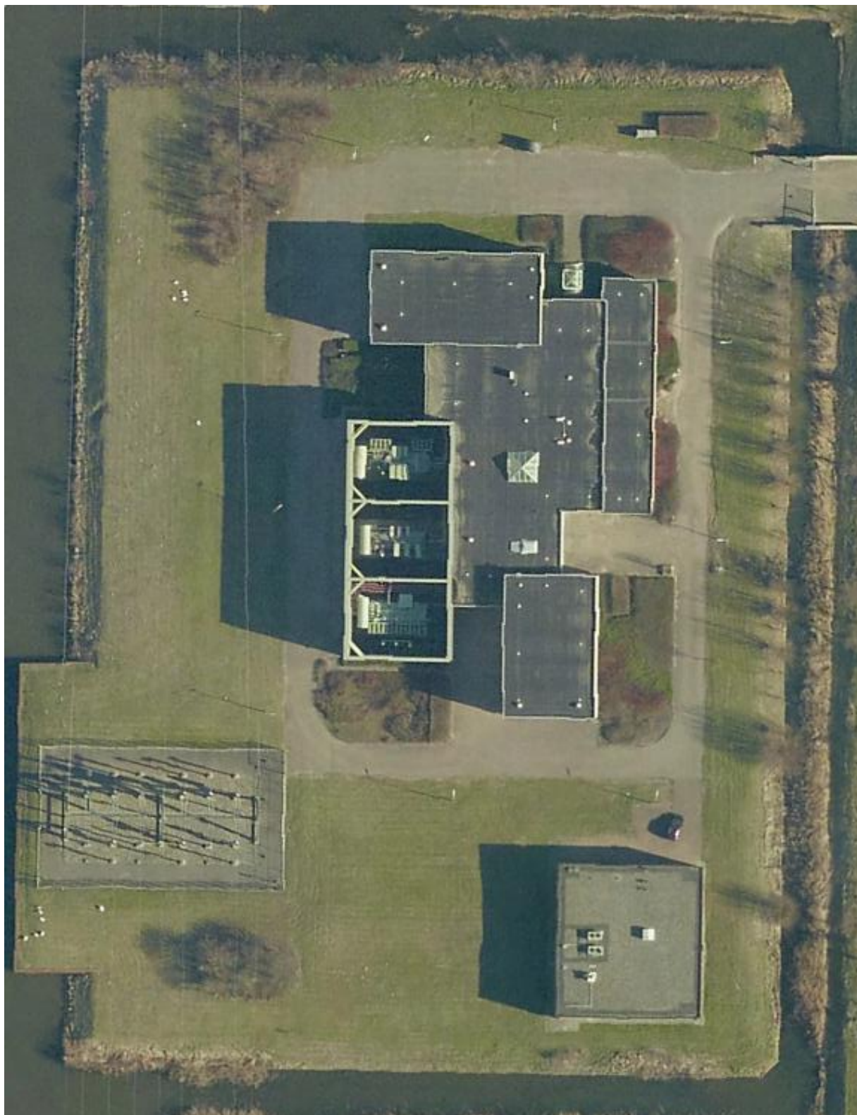
Figuur 1: Luchtfoto hoogspanningsstation Haarlemmermeer
