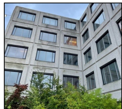
FIGUUR 3 CONSTRUCTIE OP PERCEEL 3.4
