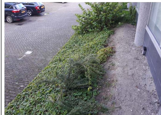
Foto 18: Groenstrook met slooppuin, cementresten en betonbrokken
