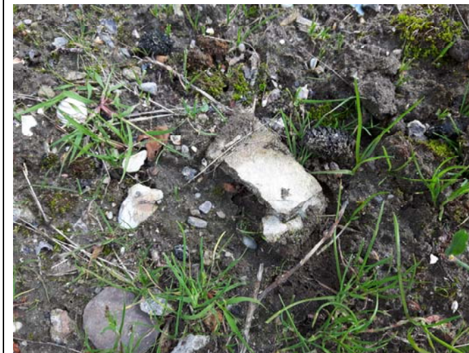
Foto 54: Asbest op maaiveld groenstrook Planetenweg 5
