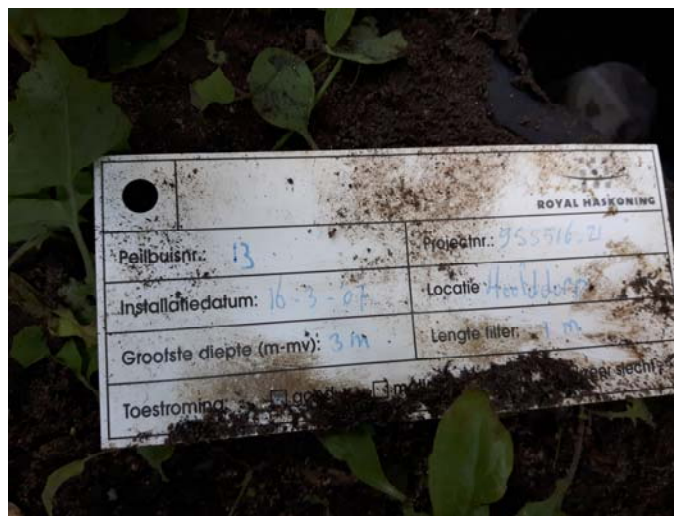
Foto 35: Label peilbuis bij noodstroomaggregaat
