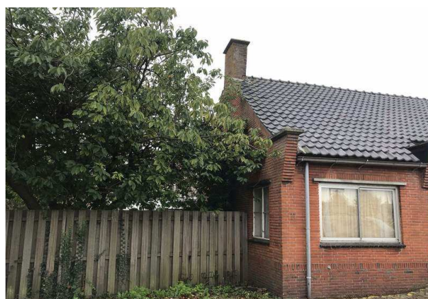
Figuur 8. Er is geen ruimte tussen de boomkruin en de achtergevel van het huis op nr. 662, vleermuizen kunnen hier niet invliegen
