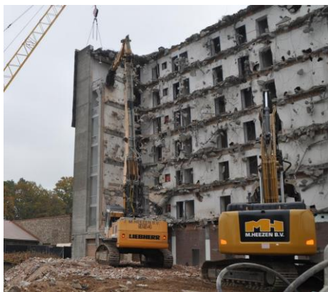
Afbeelding 5: foto sloopkraan Liebherr 954 06
