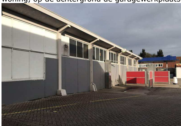
Figuur 6. Zuidwestgevel van de garagewerkplaats
