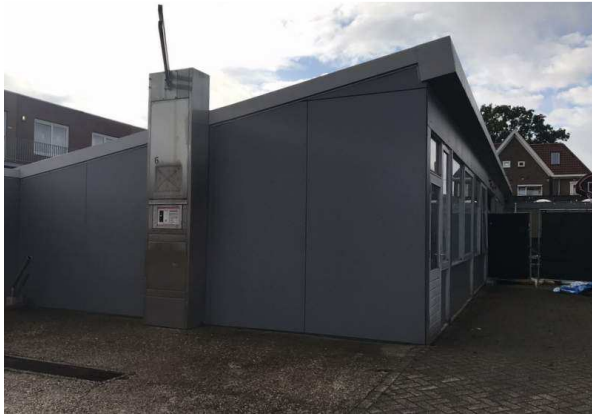
Figuur 8. Bijgebouw op het middendeel van het plangebied.
