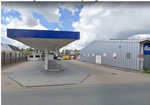
Figuur 12. Overzicht ontmantelde tankstraat met op de achtergrond de wasstraat
