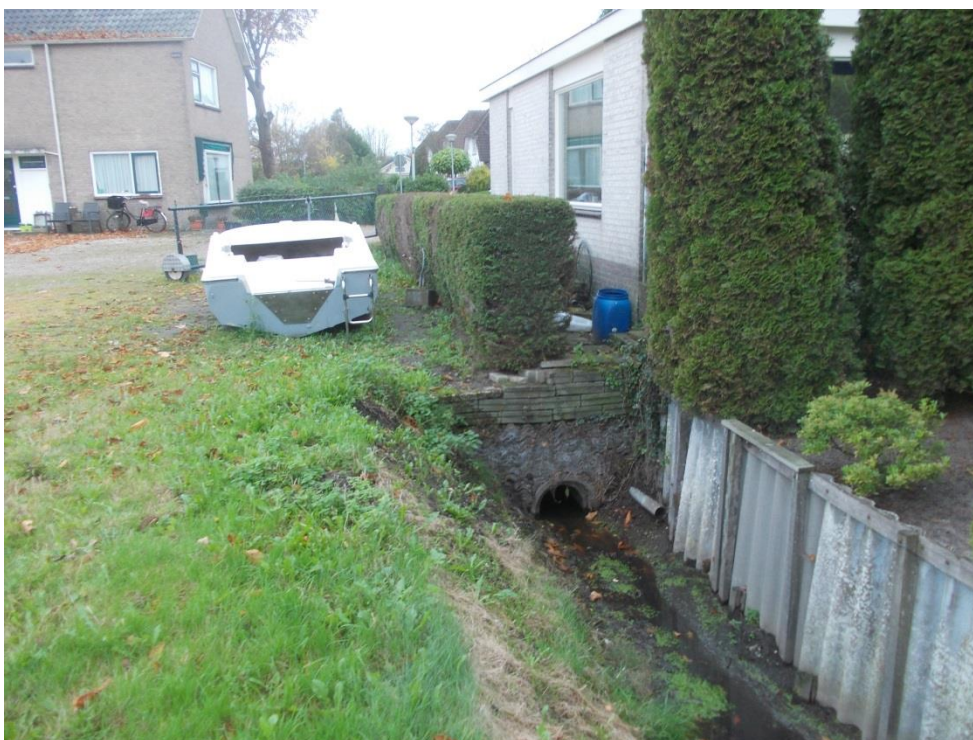
Foto 12: Zicht vanuit noordoostzijde op de dam (d.d. 03.11.14).
