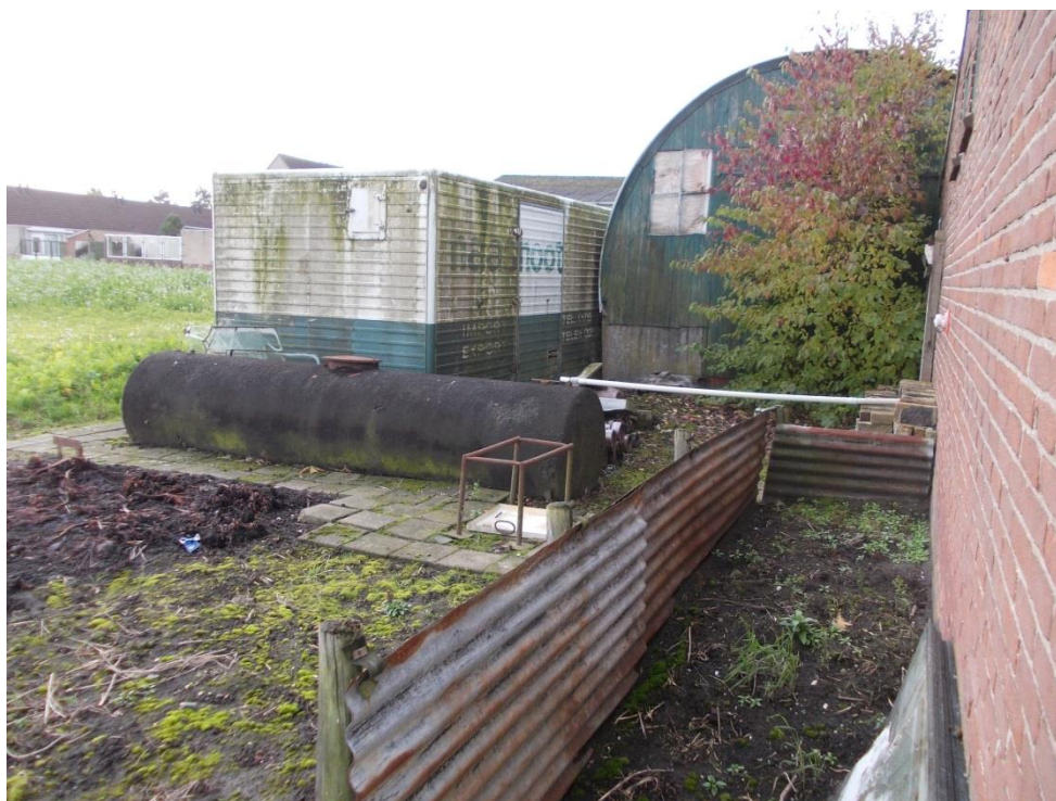
Foto 5: Zicht vanuit noordzijde op de bovengronds gelegen voormalige brandstoftank (d.d. 02.11.12).
