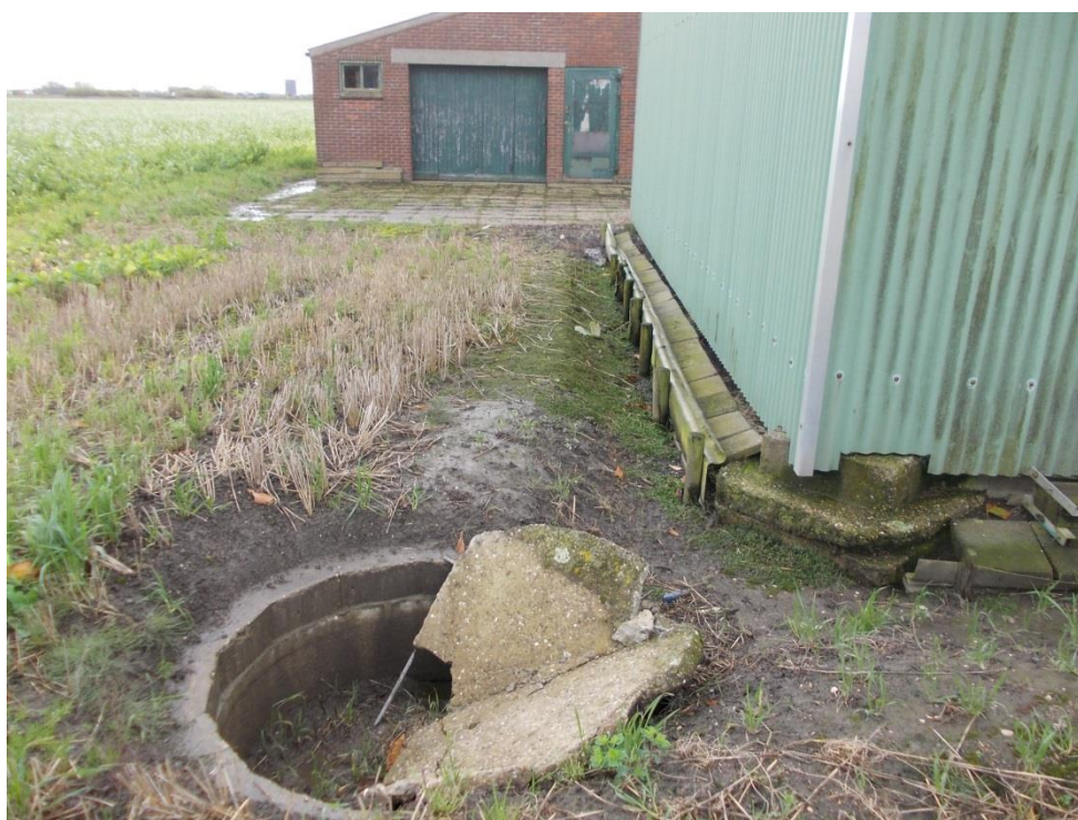
Foto 6: Zicht vanuit noordwestzijde op de noordelijke septictank (d.d. 02.11.12).
