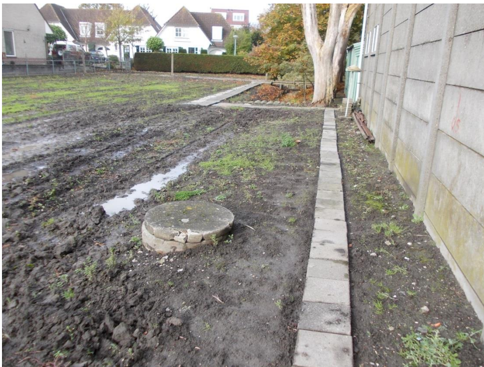
Foto 7: Zicht vanuit zuidoostzijde op de zuidelijke septictank (d.d. 02.11.12).
