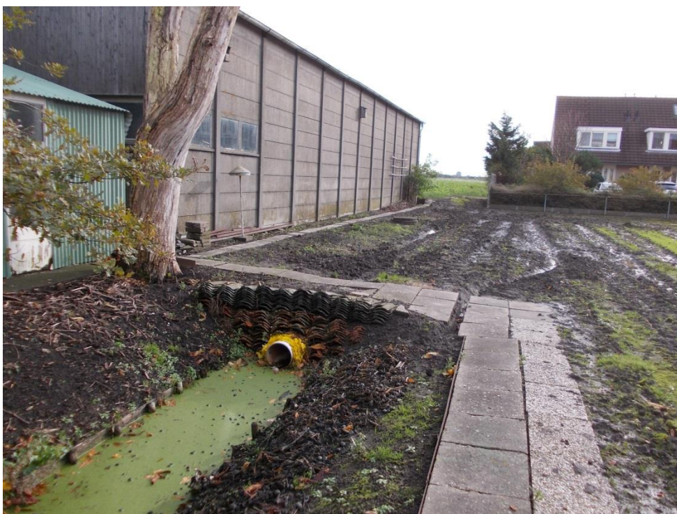
Foto 10: Zicht vanuit westzijde op de zuidoostelijke gedempte sloot (d.d. 02.11.12).
