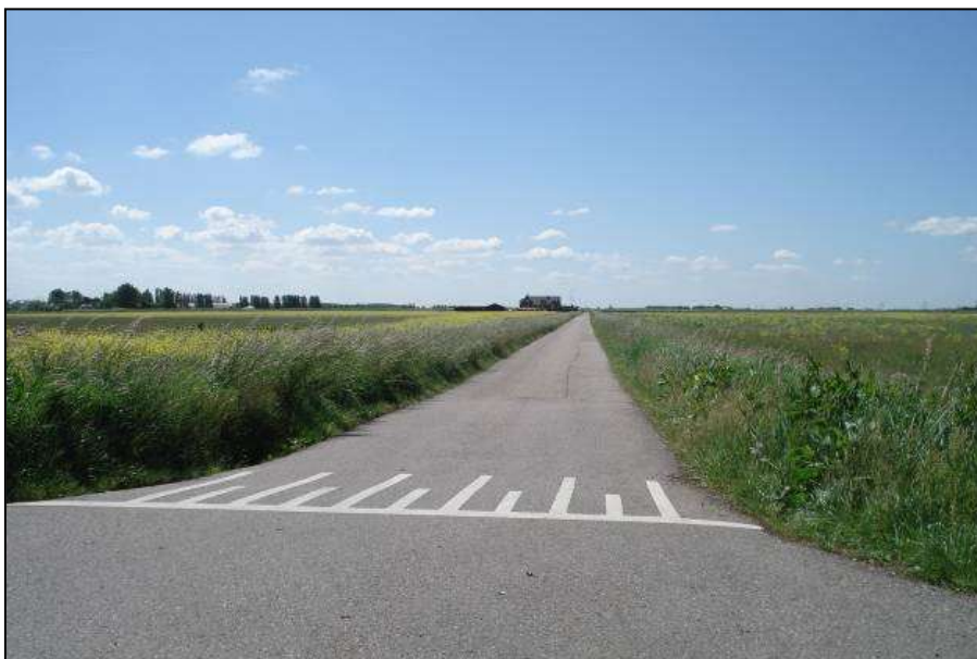
Afbeelding: Eén van de rechte wegen door het plangebied: de Noorderweg
