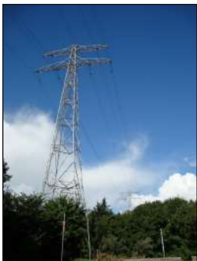
Afbeelding: de huidige hoogspanningsleiding ter hoogte van het bos
