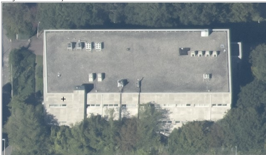
f3.1 Weergave dakinstallaties bij KPN.
