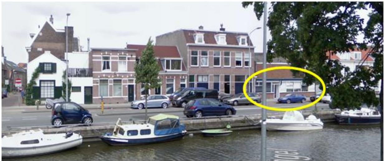
Figuur 7: projectlocatie van de huidige bebouwing in het lint langs de Lange Herenvest
