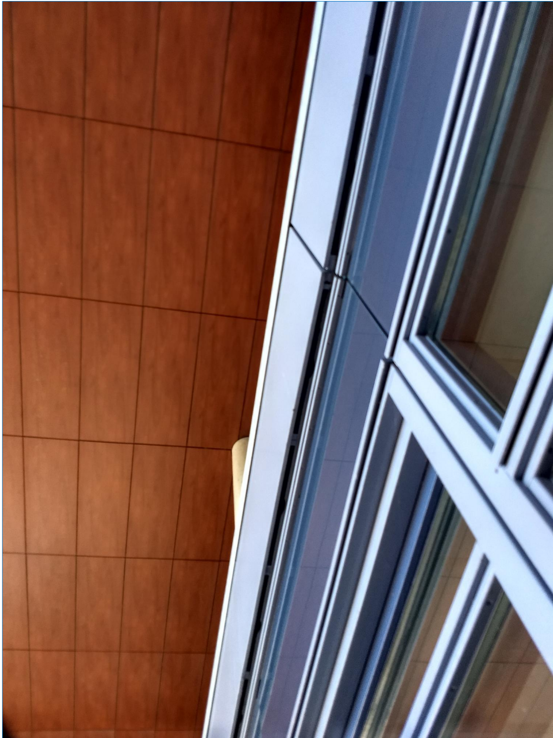
figuur 12: ruimte achter gevelbeplating hoofdgebouw
