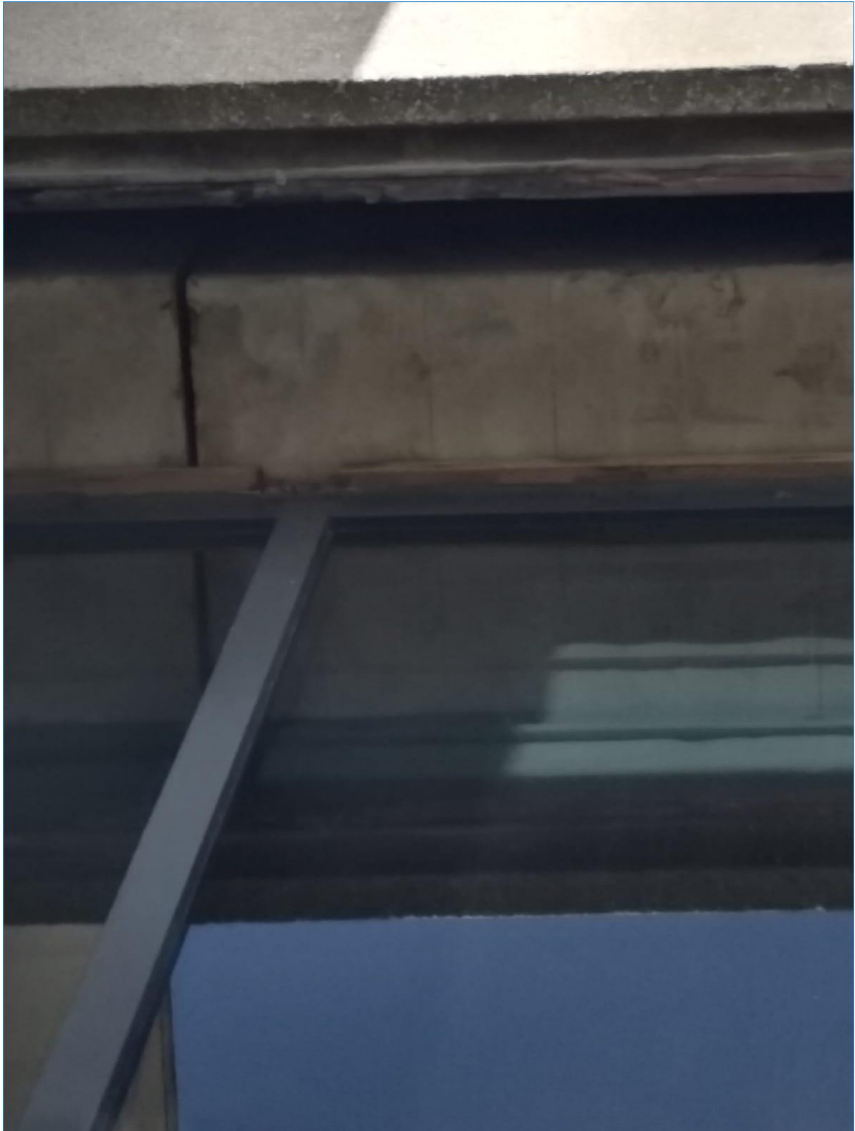
figuur 8: ruimte achter gevelbeplating bij mortuarium
