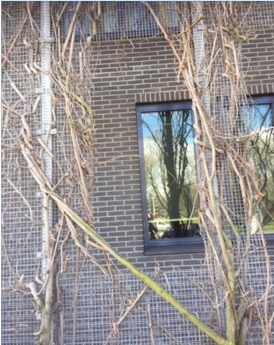
figuur 9: achterkant van hoofdgebouw, stootvoegen die zeker in de winter vrij toegankelijk zijn voor vleermuizen
