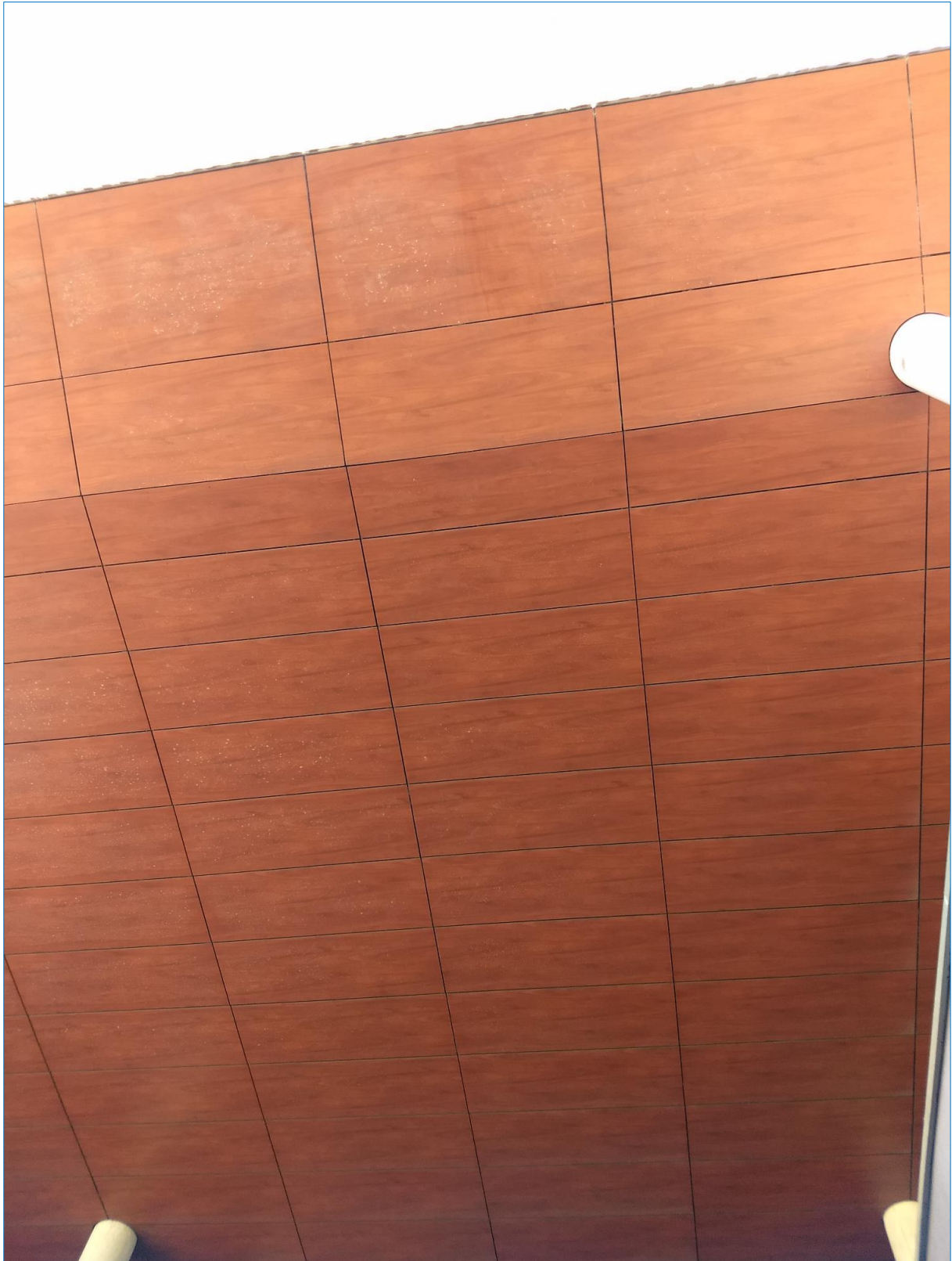
figuur 13: planfondbeplating met ruimte tussen de platen
