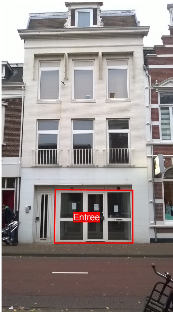
Foto 4: Plaats van de geplande entree
