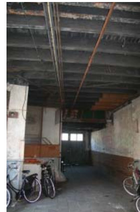
4) Doorgang en opgang
