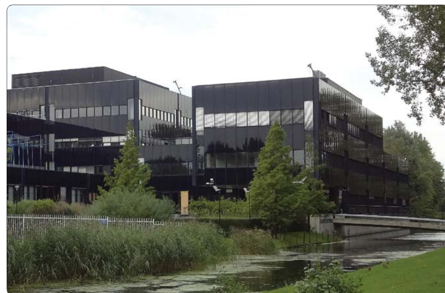
Bestaande kantoorgebouw Blauwe Wetering
