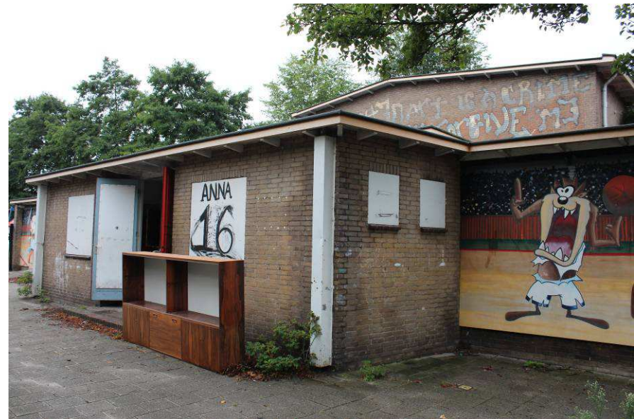
afb. 53 De oostgevel van het gymnastieklokaal.
