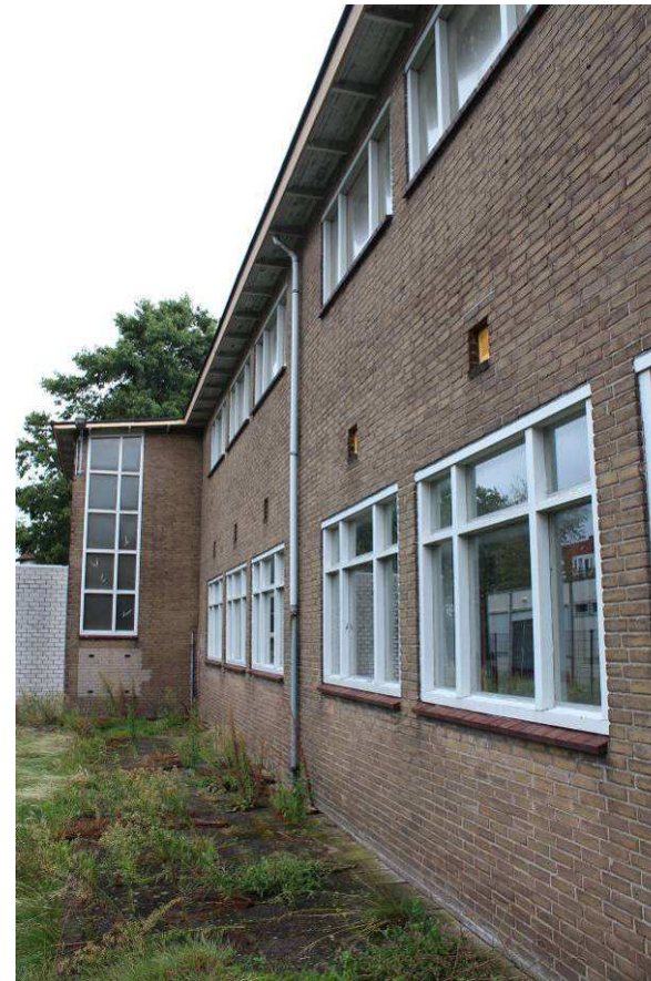
afb. 30 Westgevel van de Van Zeggelschool.
