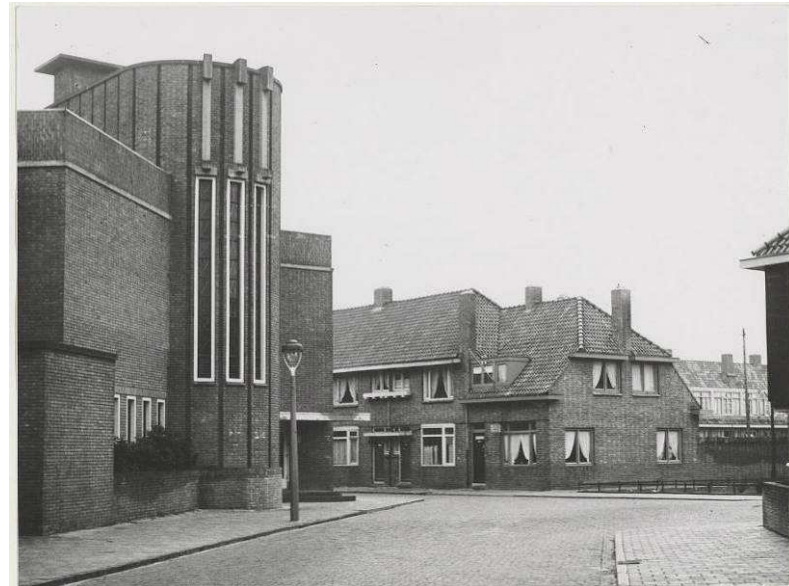
afb. 7 Foto van de voorzijde van de 1 ste Van Zeggelschool (bron: Noord-Hollands Archief NL-HlMnHA_Hrlm_17698).
