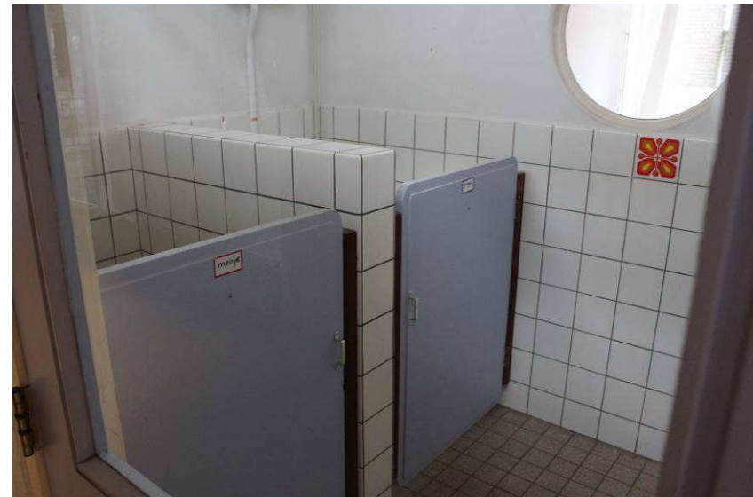
afb. 32 Eén van de drie toiletruimtes langs de gang. De lage deurtjes en het ronde venster in de tussenmuur tussen deze ruimte en het klaslokaal dienden om toezicht te houden op de kleuters.
