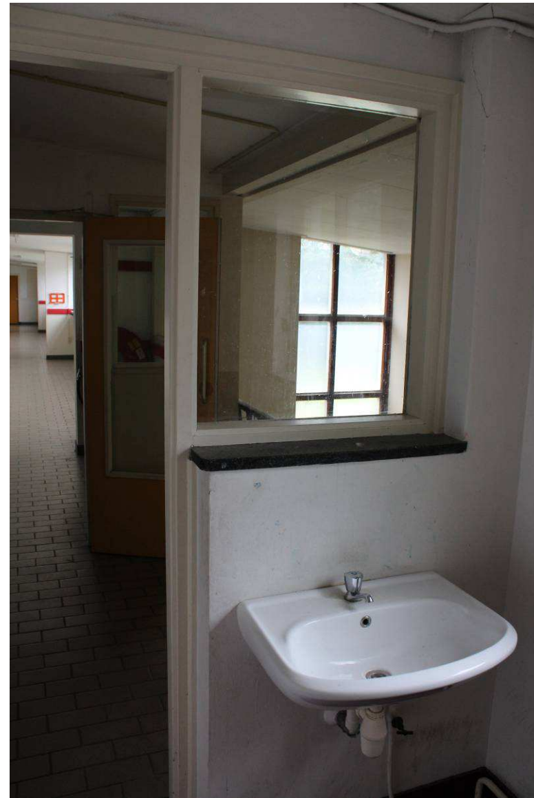
afb.2 Toiletruimte op de eerste verdieping van de Van Zeggelenschool.
