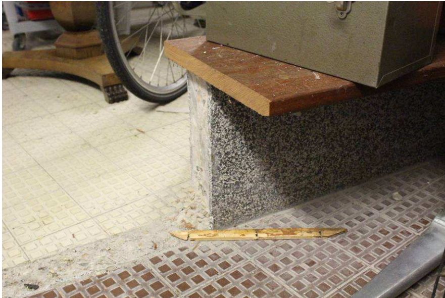
afb. 43 Een bank in één van de kleedkamers (gedeeltelijk verwijderd).
