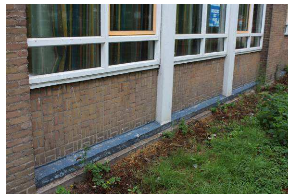
afb. 28 Gemetselde plint en de in het zicht gelaten betonconstructie in de oostgevel. De kozijnen zijn vermoedelijk in de jaren tachtig van de vorige eeuw vervangen door kunststof exemplaren.
