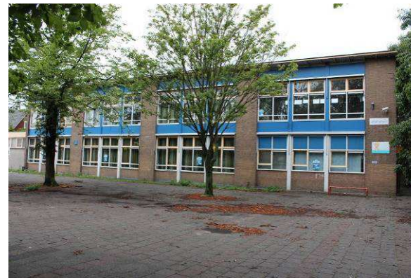
afb. 27 Oostgevel van de Van Zeggelenschool.
