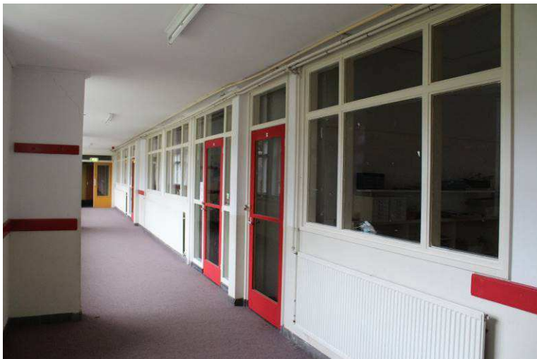
afb. 22 De gang op de begane grond van de Van Zeggelschool. Door de vensters in de leslokalen kon daglicht toetreden. Daarnaast kon vanuit de gang toezicht op de leerlingen in het leslokaal worden gehouden.
