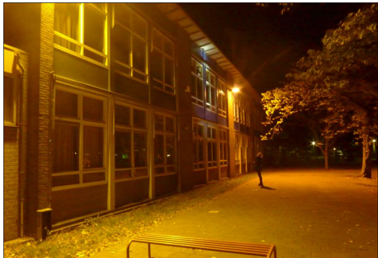
Figuur 5. De gevel van de school is sterk verlicht, en daardoor weinig aantrekkelijk voor vleermuizen om te verblijven.
