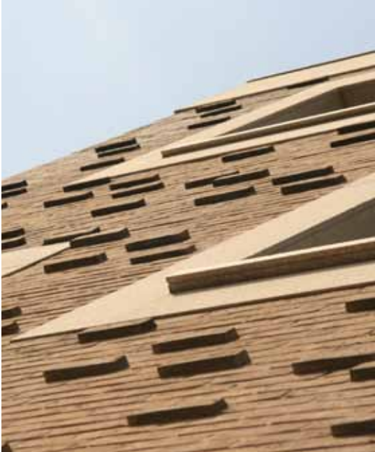
Voorbeelden van bijzondere verbanden in het metselwerk op koppen
