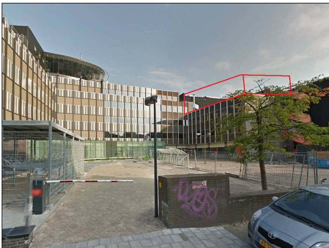
figuur 6: locatie optopping dwarsvleugel achterzijde Ruychaverstraat
