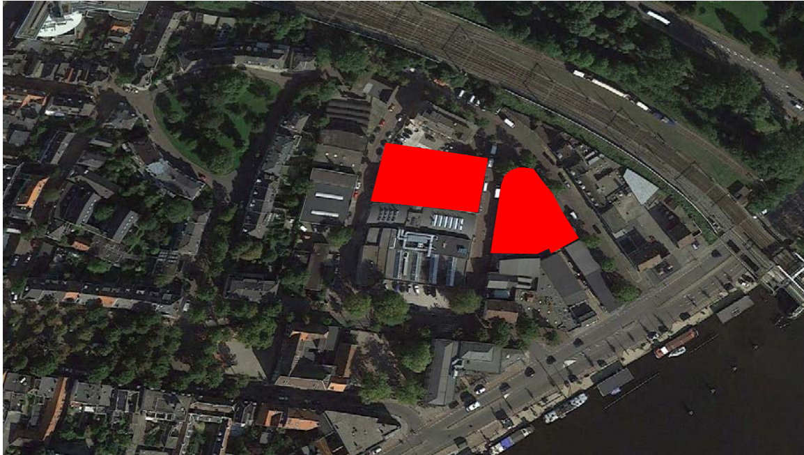
Figuur 1: Overzicht situatie Gonnetstraat 22 (rechts) en Gonnetstraat 26 (links) (bron: Google)
