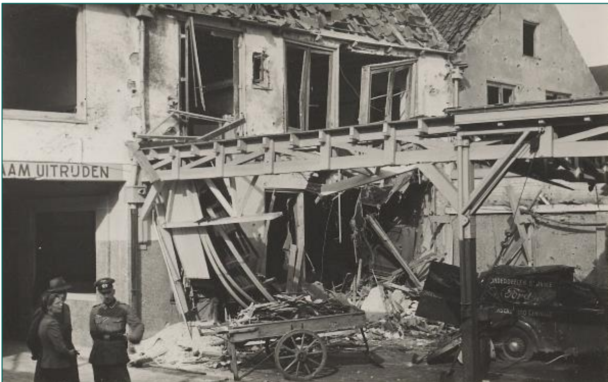
Figuur 47: Bomschade in de Fordgarage (Bron: Beeldbank NHA, NL-HlmNHA_Hrlm_01947).
