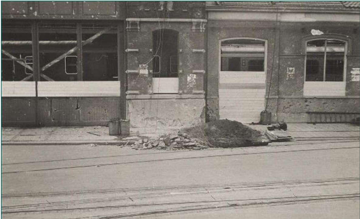
Figuur 46: Bomschade (gesprongen ruiten en deuren, sporen van bomscherven en een krater) voor het Beynesgebouw (Bron: Beeldbank NHA, fotonummer NL-HlmNHA_Hrlm_02236).
