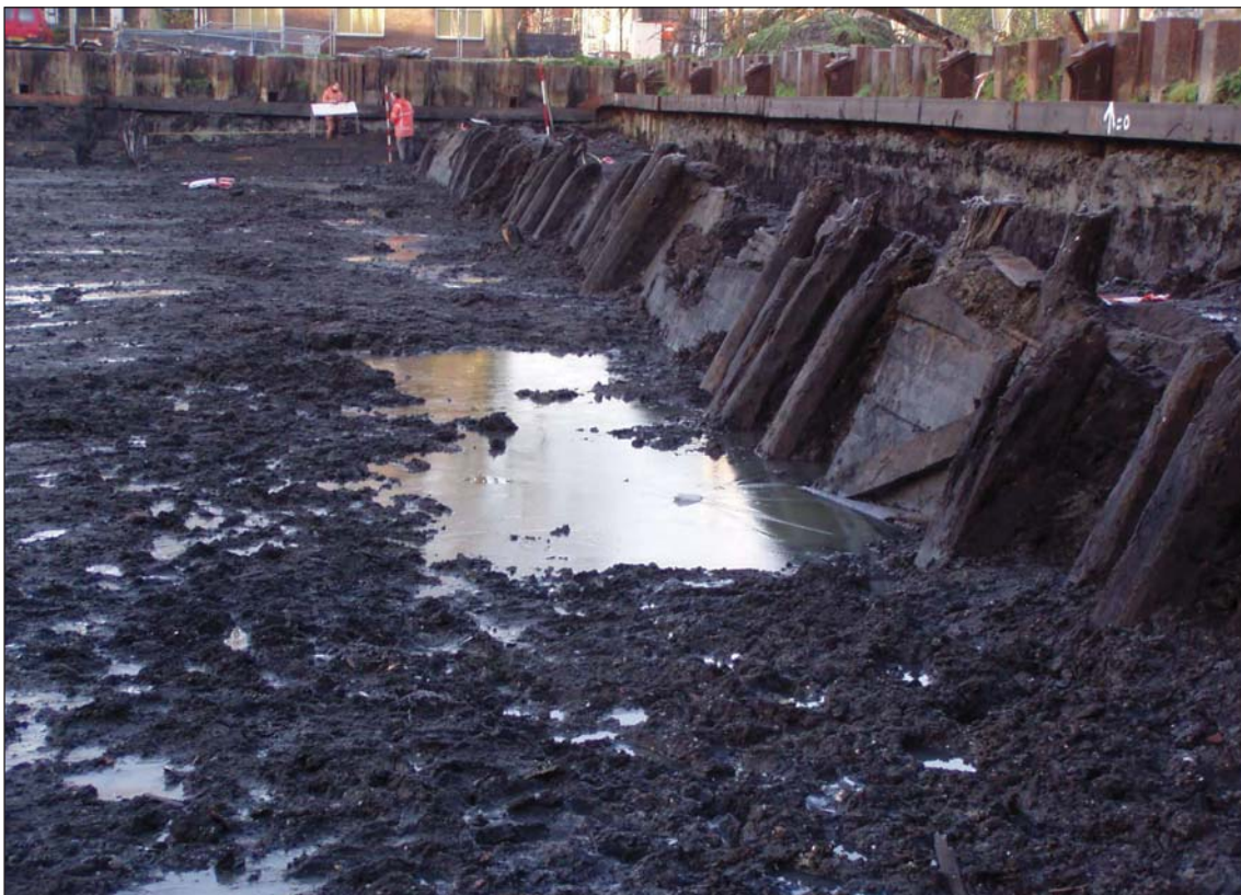
Afb. 22 De houten beschoeiing van de Nieuwe Haven, blootgelegd tijdens de opgraving binnen het plangebied Fruittuinen.
