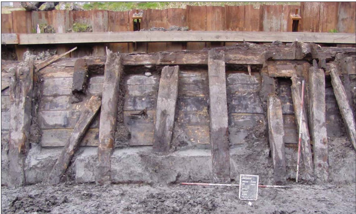
Afb. 24 De houten beschoeiing van de Nieuwe Haven, blootgelegd tijdens de opgraving binnen het plangebied Fruittuinen.
