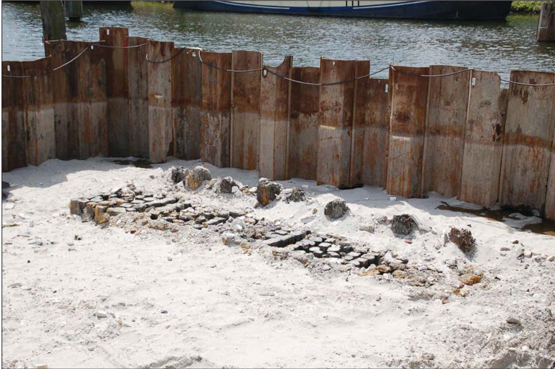
Afb. 29 Vooraan de roosterfundering van de bakstenen aanbrug van de Compagniesbrug. Daarachter vermoedelijk palen van een houten juk van de brug.
