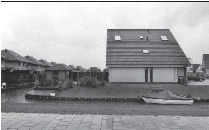
Figuur 13. Opvallende dakvlakken vragen om een zorgvuldige plaatsing van dakramen en dakkapellen
