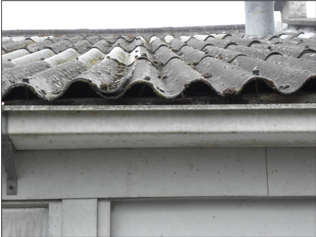
Impressie van het dak dat waarschijnlijk geschikte broedlocaties aan de huismus biedt.
