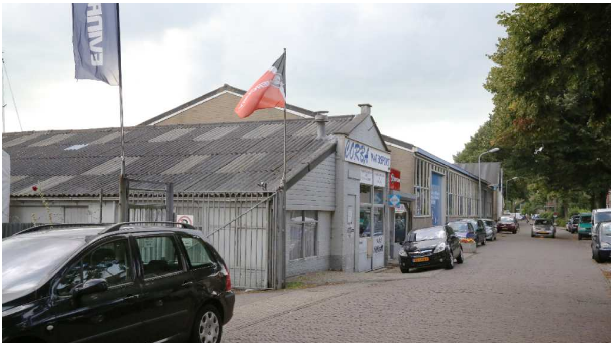
Foto 2: foto van het te ontwikkelen terreindeel, fase 2 (met te slopen winkel, gezien vanaf wegzijde en daarachter fase 1)
