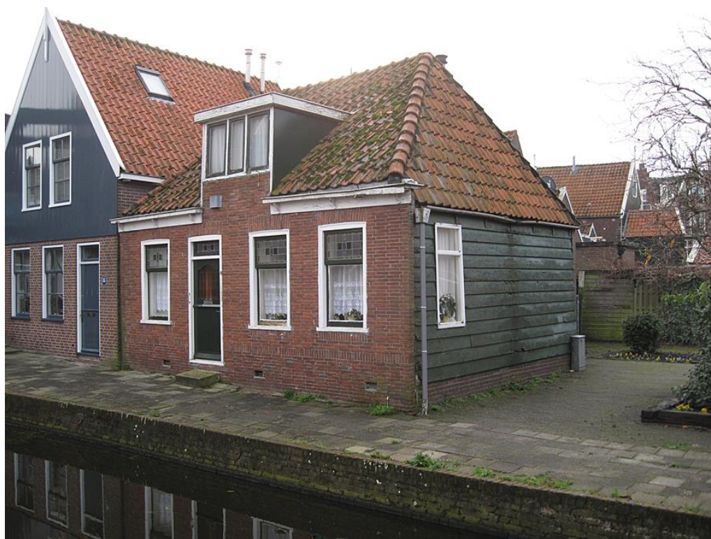
Voorgevel en rechter zijgevel Dril 83
