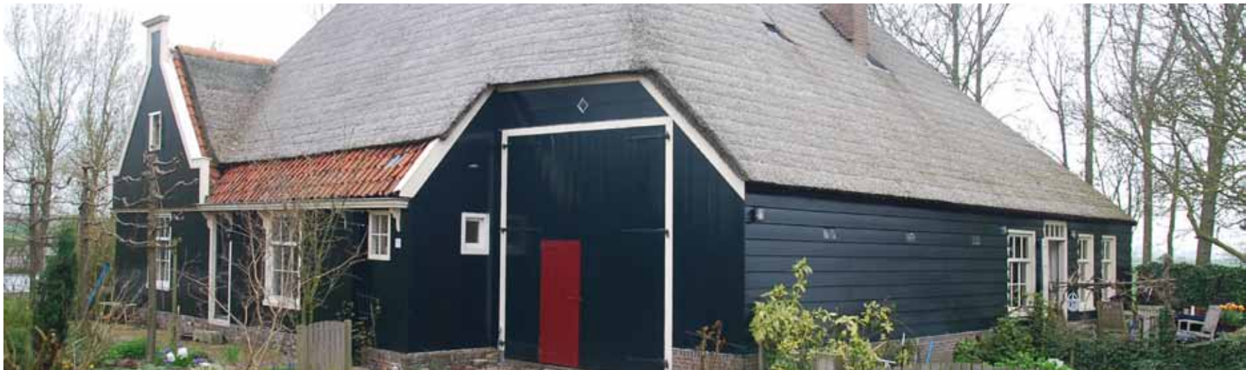
Transformatie van een stolpboerderij (Beets)
