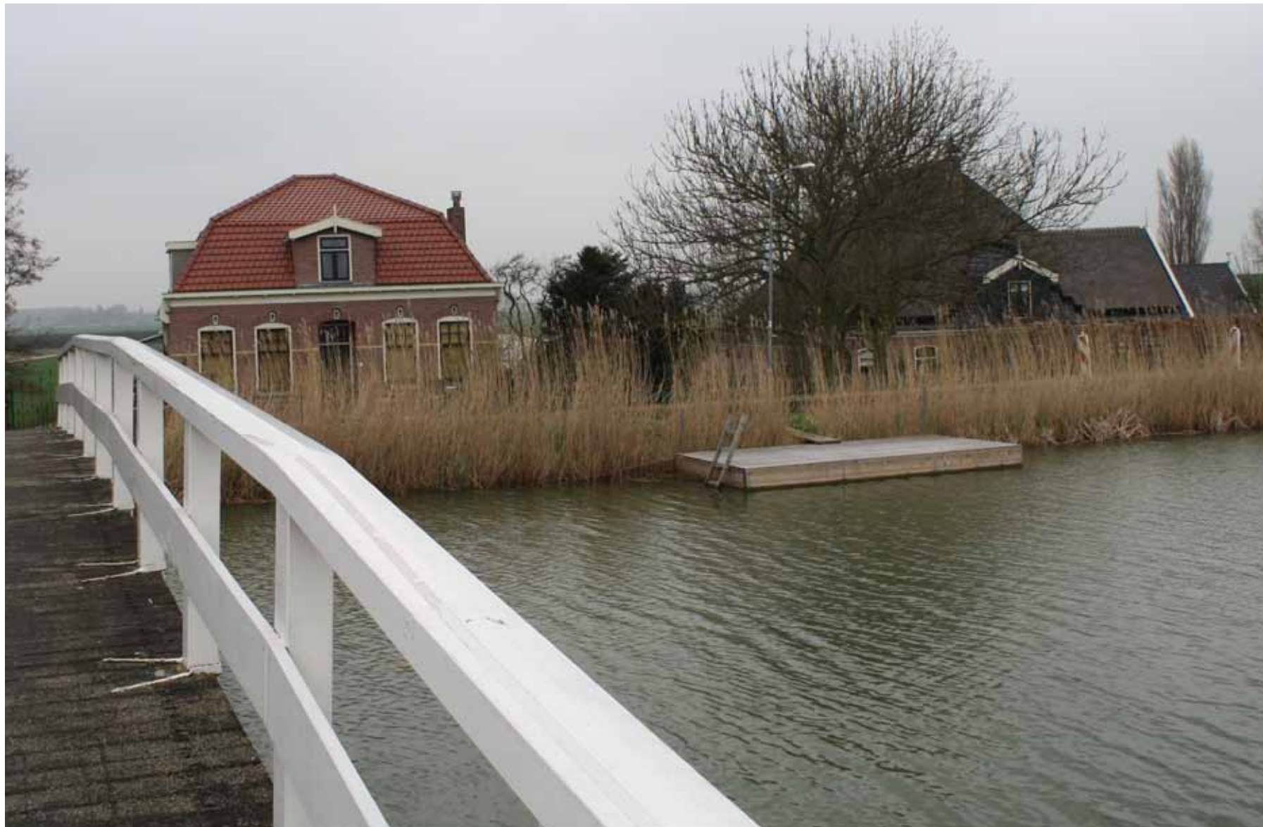
Een ingetogen vormgegeven brug en vlonder in de Korsloot (Schardam)
