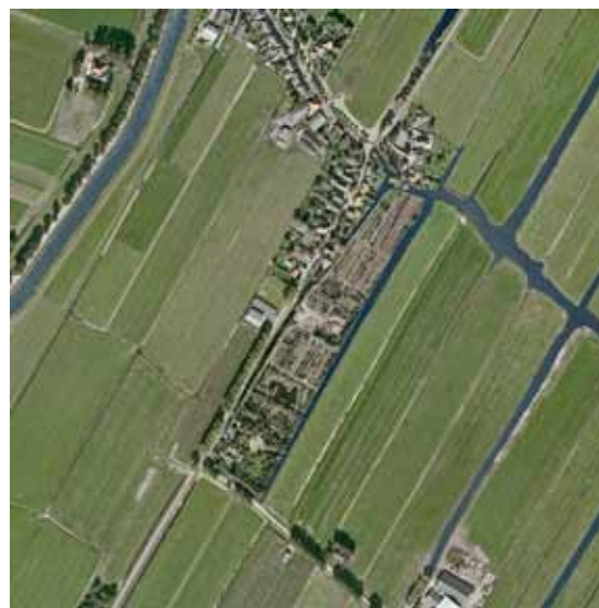
Luchtfoto huidige situatie Hobrede
