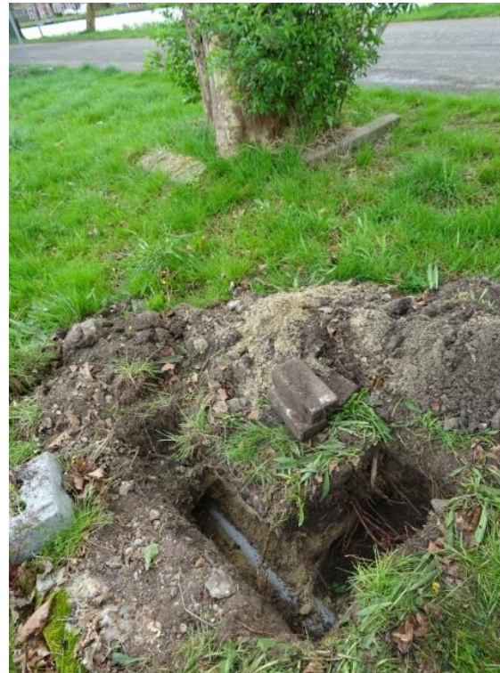
In sleuf D (parallel aan de fundering) bevindt zich op 43 cm-mv een PVC leiding. Sleuf E (haaks op sleuf D) laat zien dat de bodem onder de parkeervakken intensiever doorworteld is.
