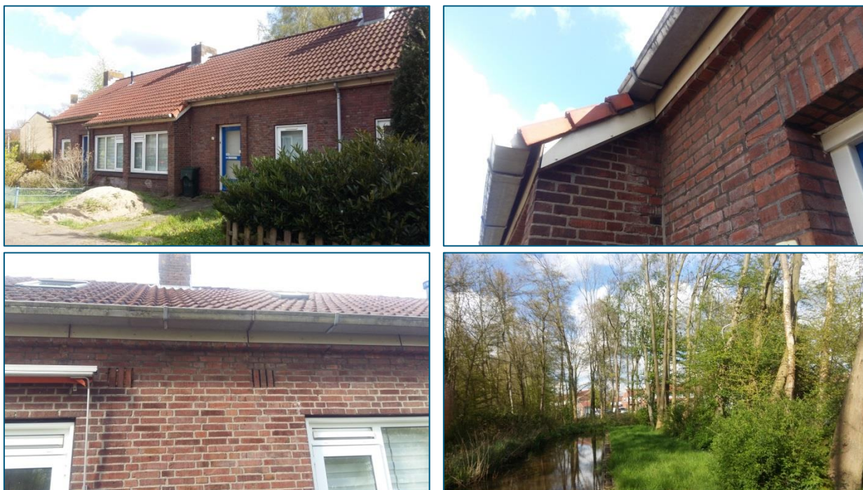
Figuur 4: De huisjes aan de Harmonielaan met voor vleermuizen geschikte structuren (daklijsten, dakpannen, spouwgaten) en rechtsonder een dwarsloot langs de westrand van de parkeerplaats, geschikt foerageergebied.
