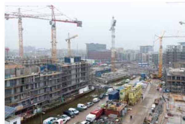
3 Holland Park in aanbouw
