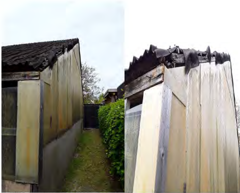
Figuur 14: Dakbedekking schuur projectlocatie.
