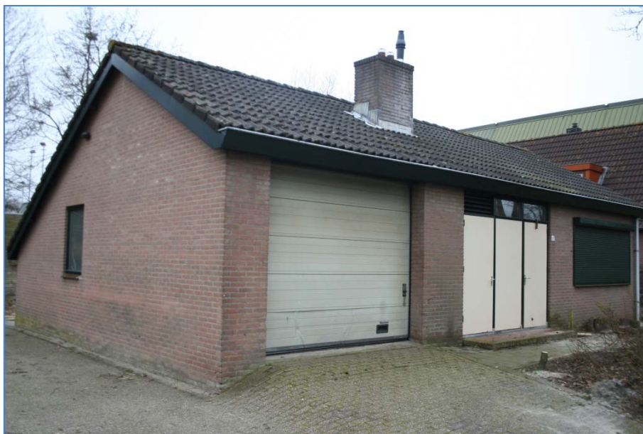
Te slopen gebouwtje binnen het plangebied.
