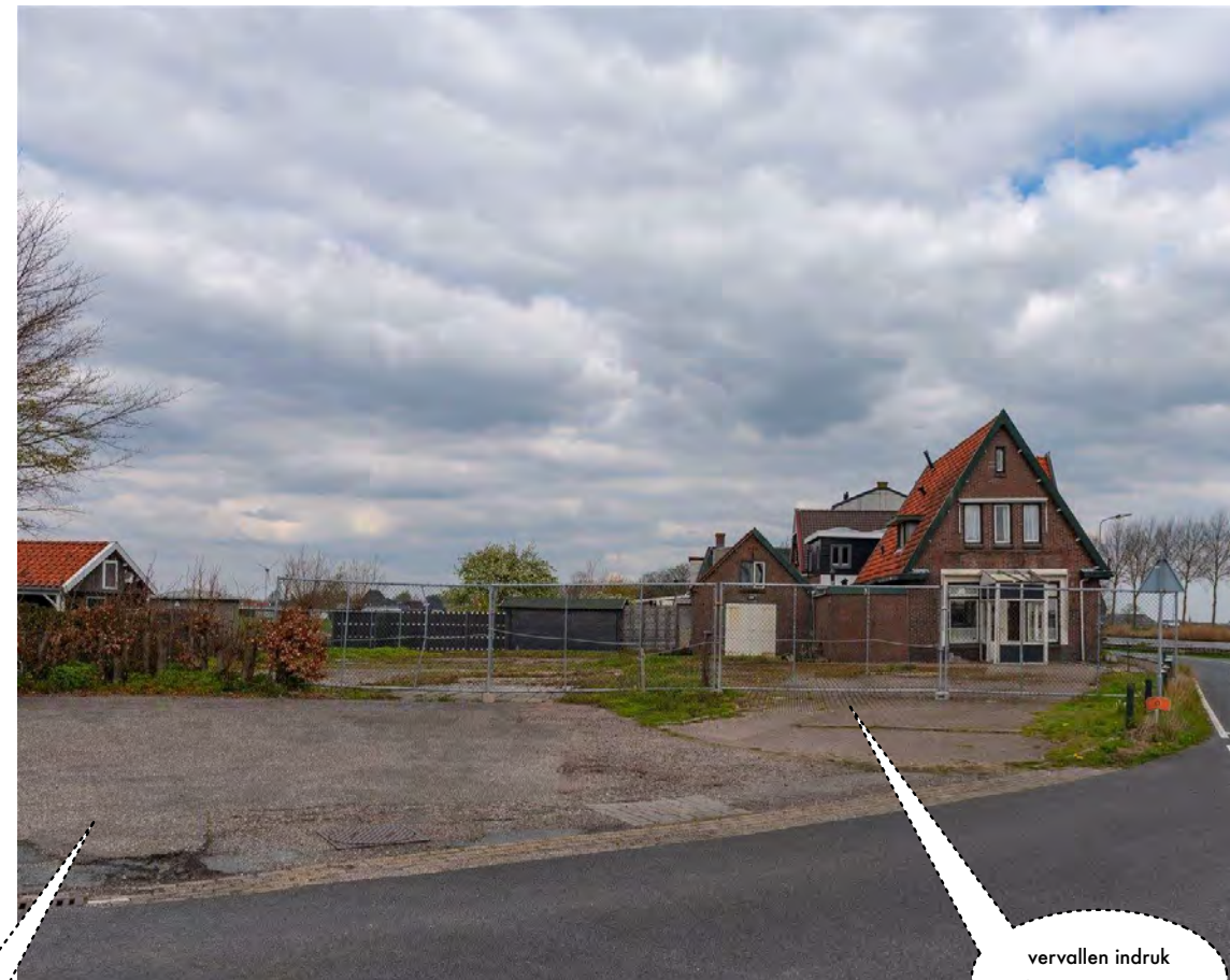
aanzicht kavel vanaf het zuiden
