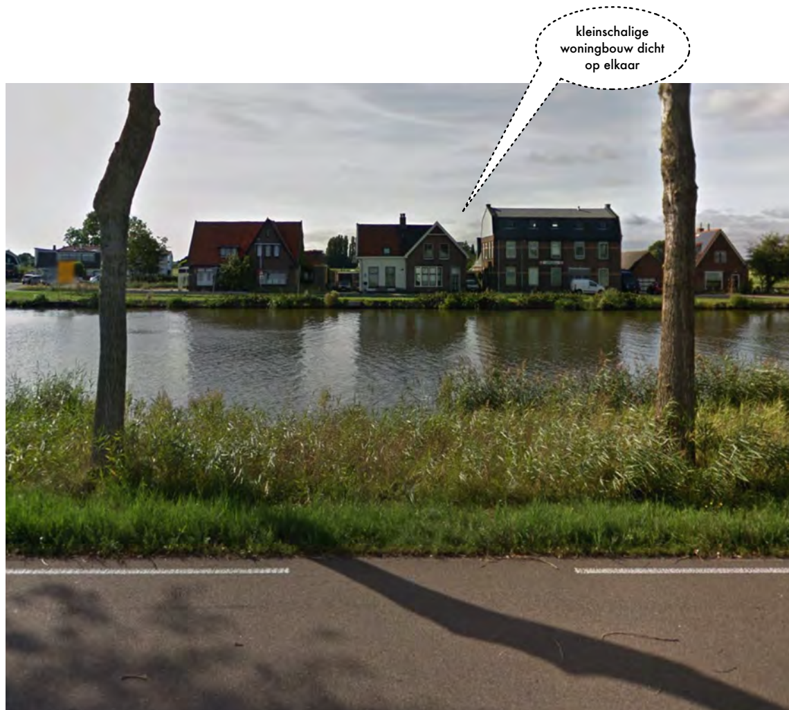
aanzicht woningen Schouw 1 - 5
