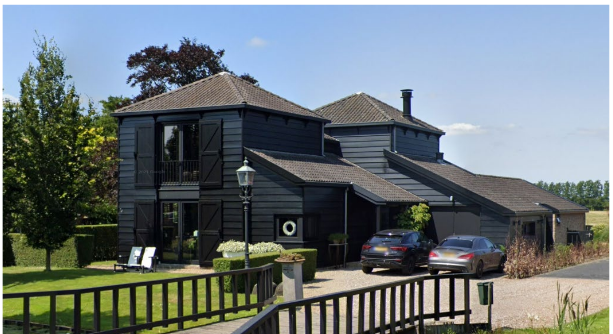
Referentieproject nieuw bijgebouw
