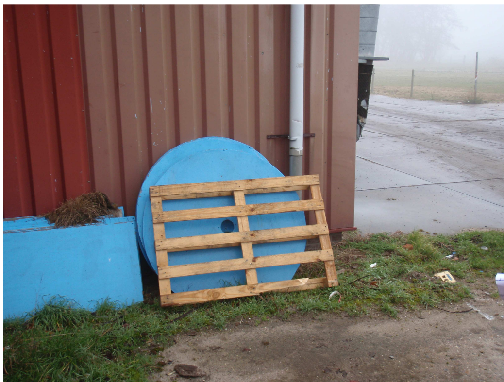
Foto 8: Vak 10, asbestverdachte gevelplaten
