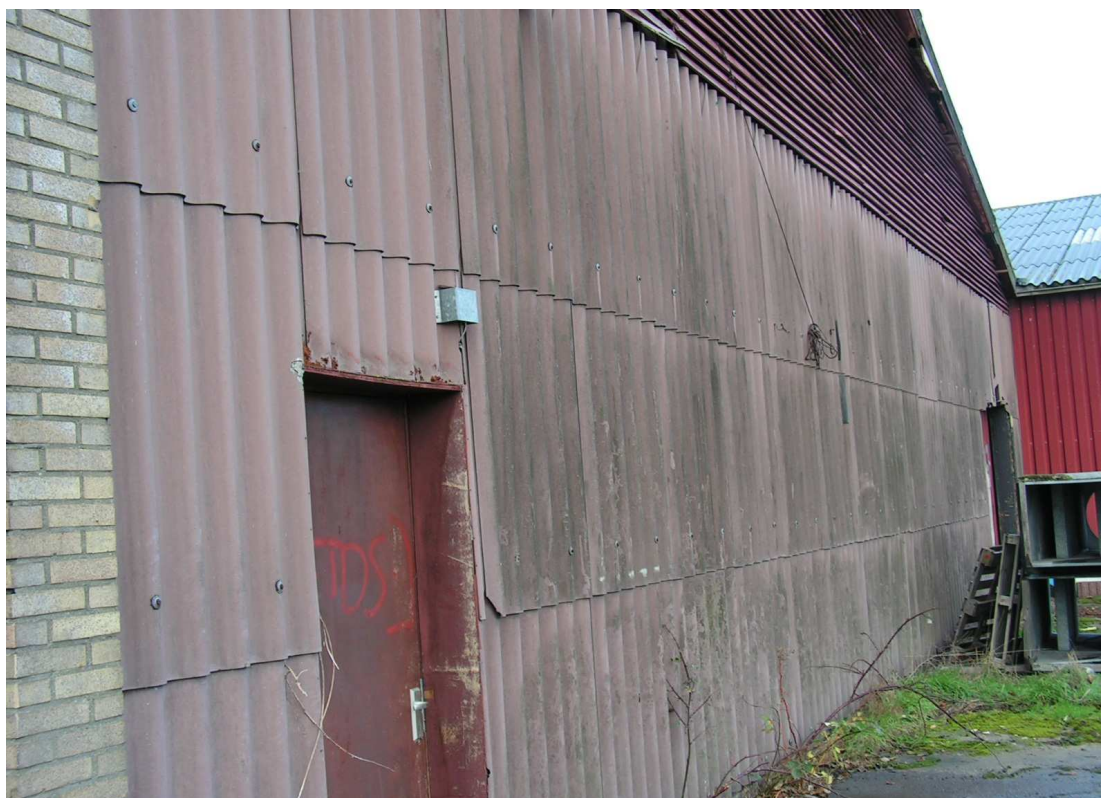
Foto 8: Vak 10, asbestverdachte gevelplaten
