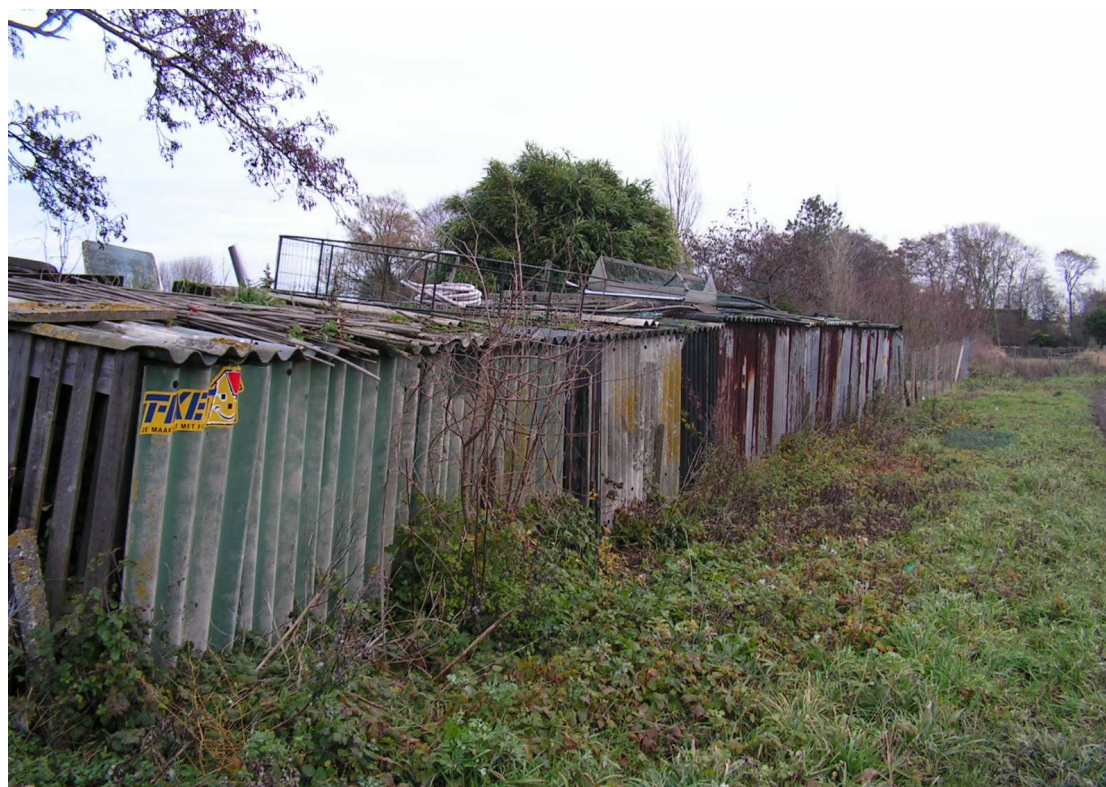
Foto 10: Vak 11, asbestverdachte schoeiing
