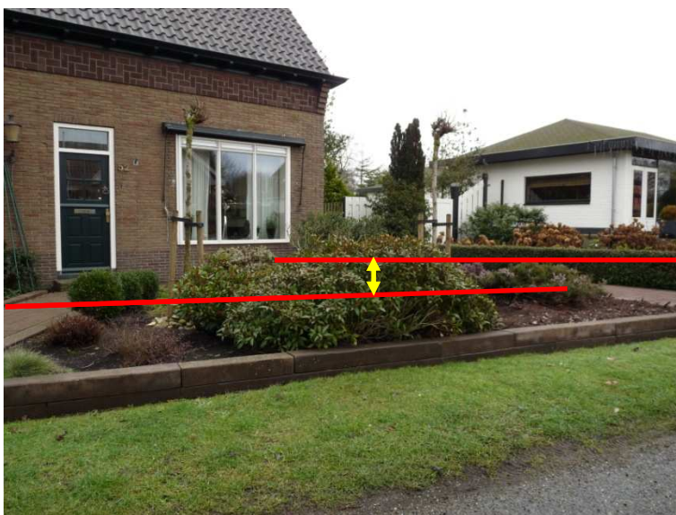
Figuur 2.4. Woningen aan de Visweg met verschillende vloerpeilen
