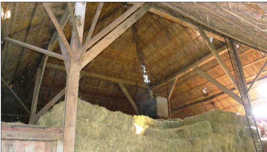
Binnenzijde schuur aan het Dronenlaantje
